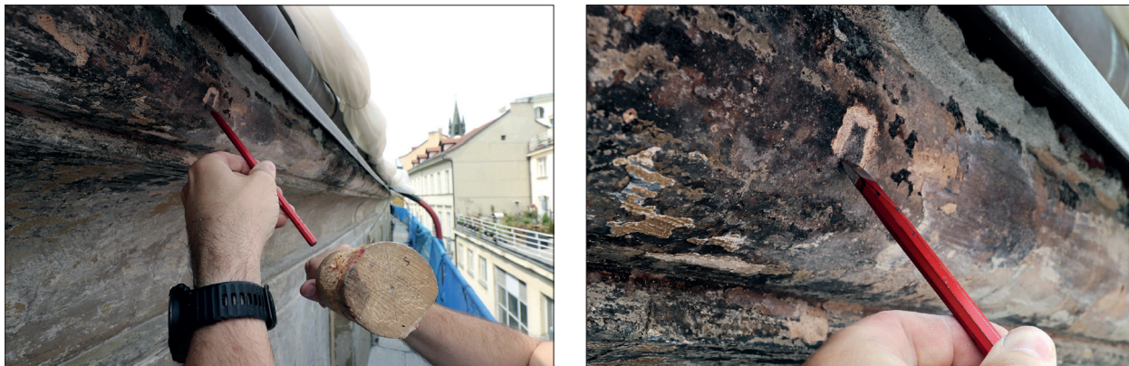
Obr. 4 a 5. Informační hodnotu odebraných vzorků ovlivňuje nejen vytipování místa, ale také zvolená technika odběru vzorků a použití přiměřených nástrojů. Při odběru je třeba zajistit, aby vzorek obsahoval celé souvrství úprav z vytipovaného místa včetně podkladu.
