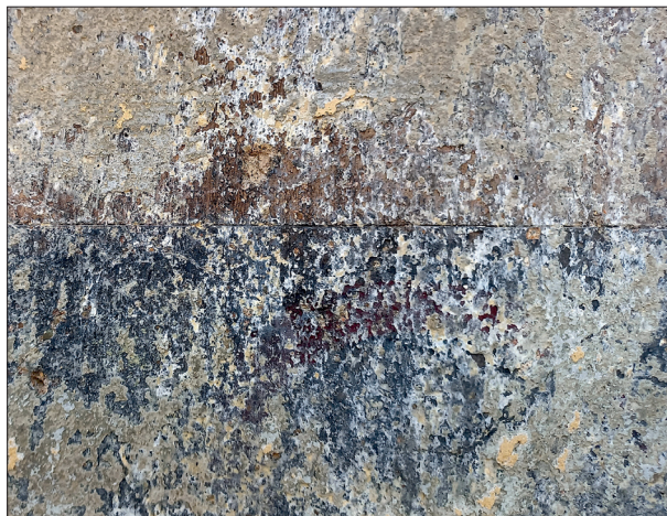
Obr. 21. Reálná nálezová situace s odhalenými, značně poškozenými původními úpravami fasády. Iluzivní kordonová římsa oddělená patrným rysem je provedena tmavě šedě, na tmavém pozadí jsou v ploše viditelné nepravidelné, jasně ohraničené červené skvrny, které byly in situ interpretovány jako mramorování. Stratigrafii úprav v místě červeného mramorování, která této hypotéze odpovídá, zachycuje obr. 20.
